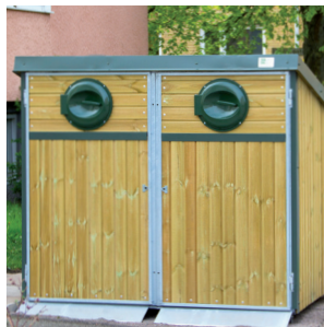
Beklädnad av tryckimpregnerad spårpanel. Plåt detaljer i grönt.
