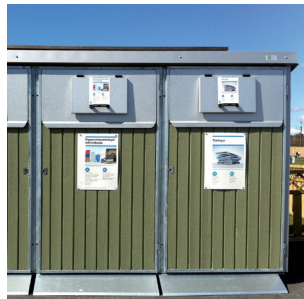
Beklädnad av målad spårpanel, plåt runt inkastluckor i aluminiumkulör. Takplåt och lister i aluminiumkulör.
