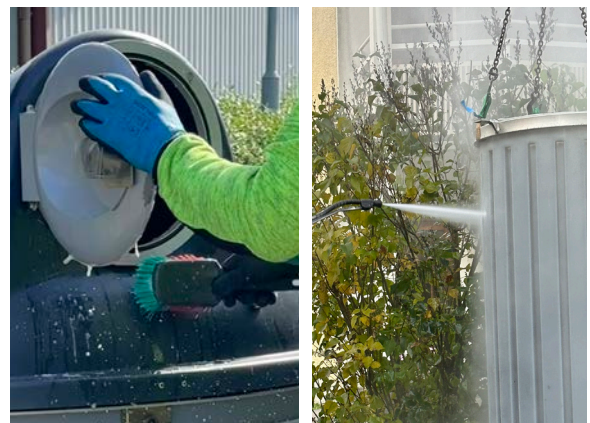
Rengöring av en helt nedgrävd underjordsbehållare
